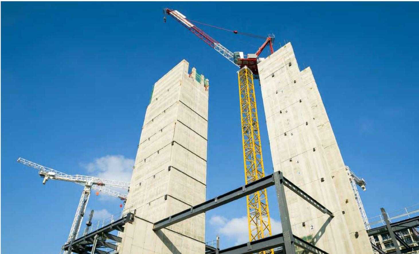
hausturm – aus Beton vorgesehen. Der Treppenhausturm aus Beton sichert im Brandfall dann zusätzlich die Fluchtwege.
