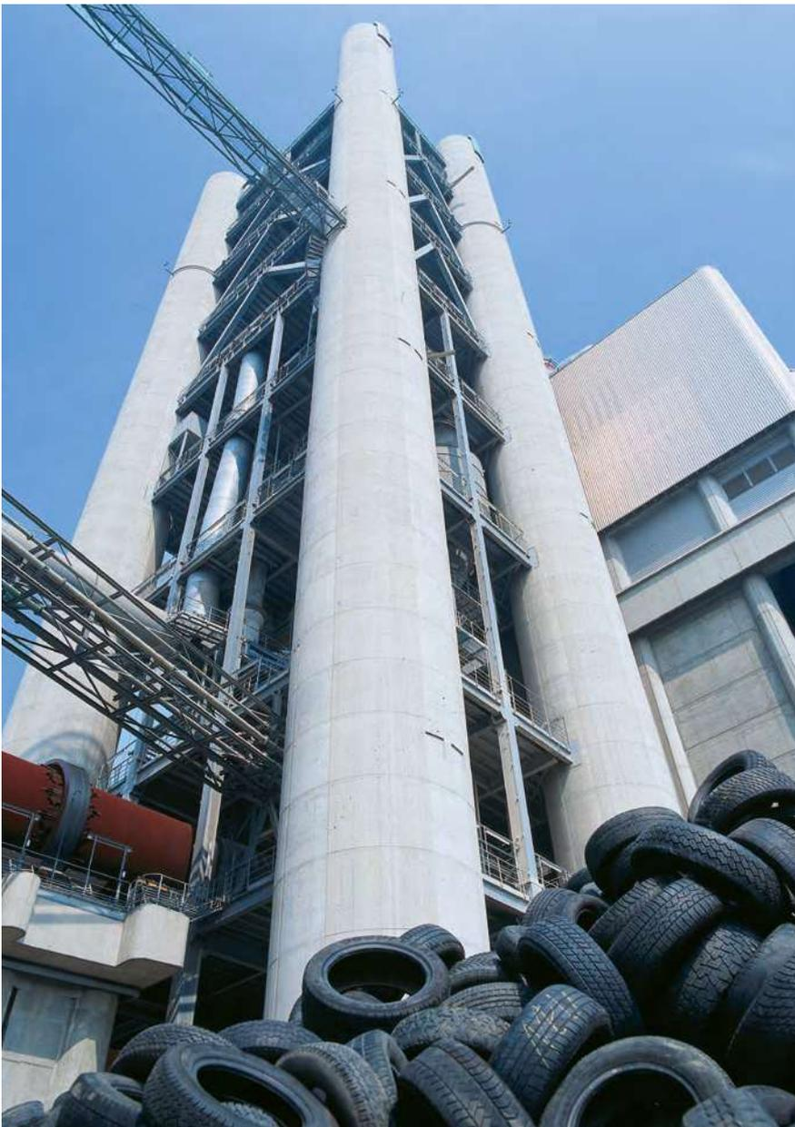
Etwa die Hälfte aller in Deutschland anfallenden Altreifen wird in der Zementindustrie als Energieträger und Rohstofflieferant verwertet. Die bei der Verbrennung entstehenden Aschen und Stahlkarkassen werden als notwendige Rohmaterialbestandteile in den Portlandzementklinker eingebunden.
